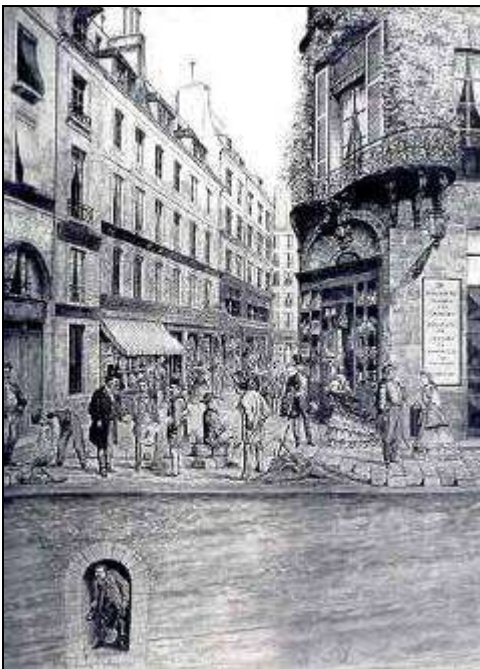
Égout de la Rue Thévenat, 1830
