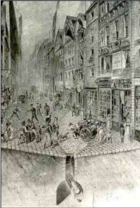
Égout de la Rue Saint-Senis, 1810
